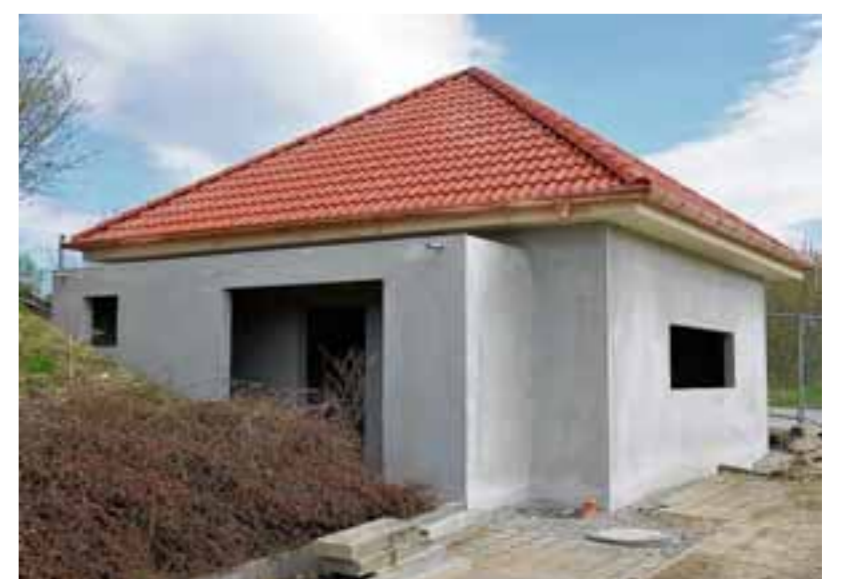
Inzwischen steht der Rohbau des Planetariums. Martin Mayer kann es kaum erwarten, endlich die ersten Vorführungen zu begleiten.
