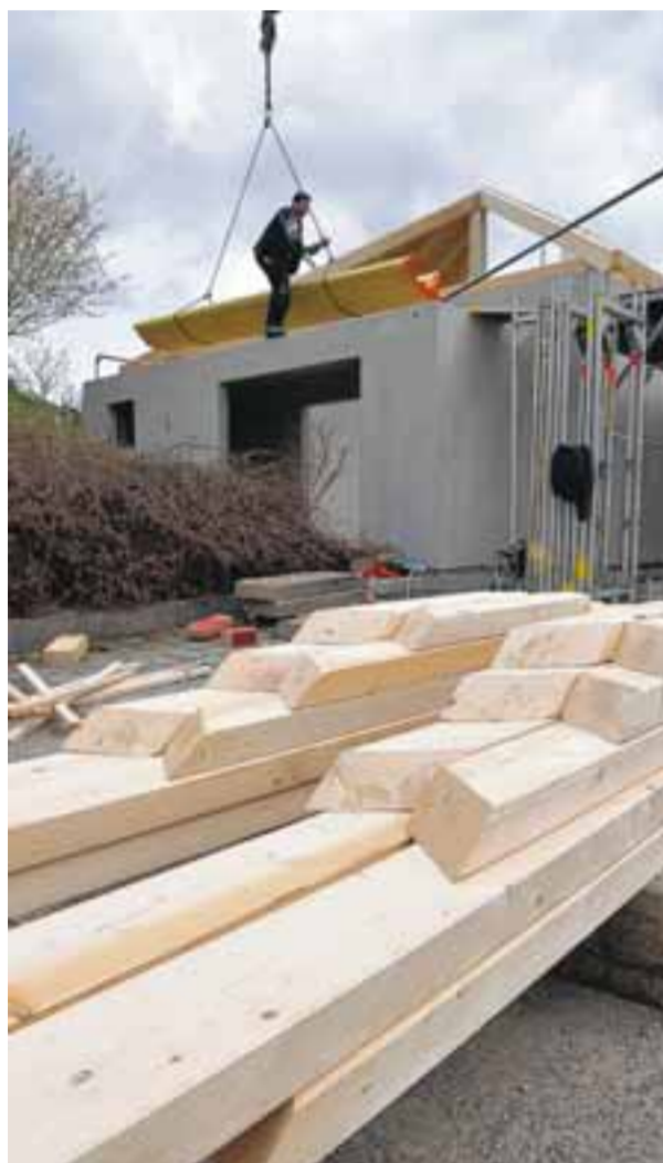
Als Ergänzung zur Sternwarte soll in Streitheim ein Planetarium entstehen. Doch zunächst muss das Dach montiert werden.
