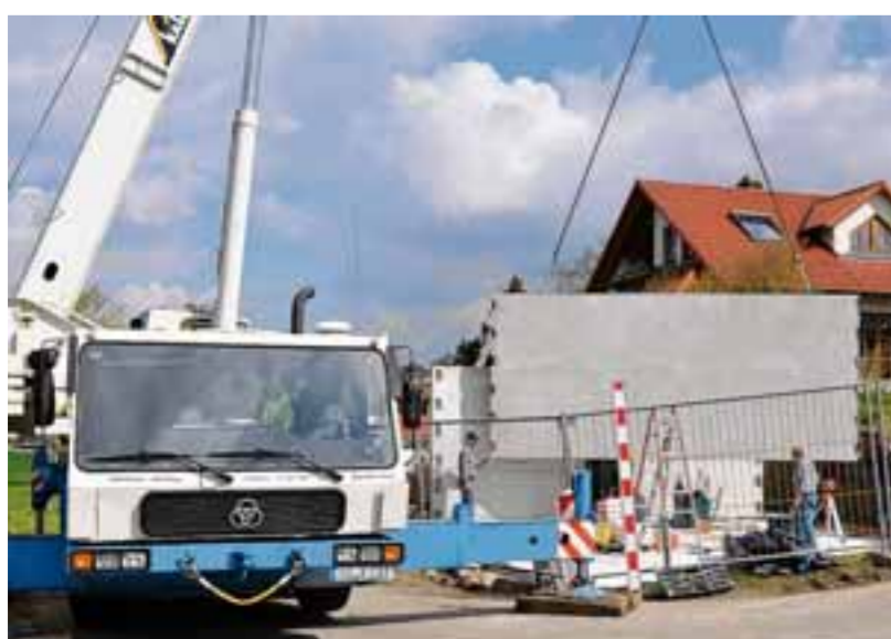
Mitte April wurden bereits die Betonfertigteile des Planetariums auf das Fundament gesetzt.
