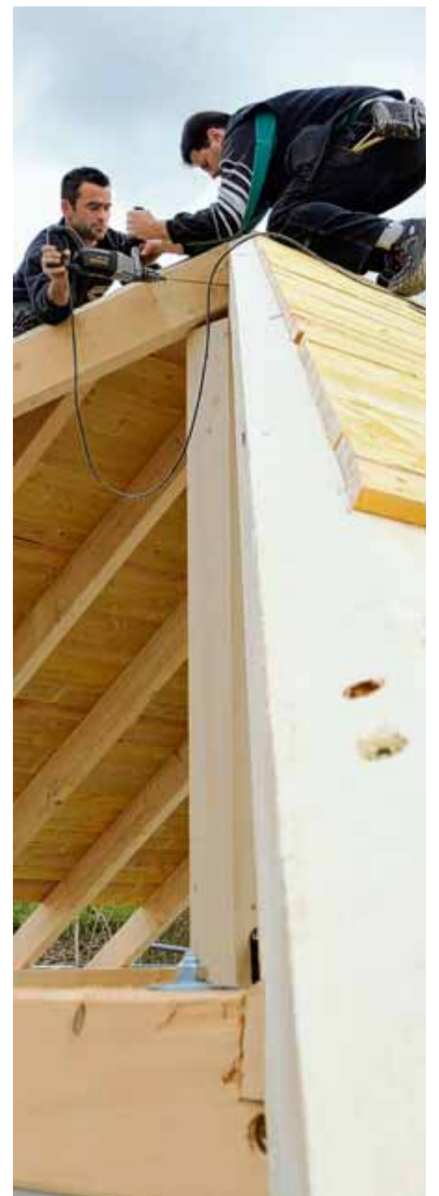
Zunächst hält noch ein Stützpfeiler in der Mitte des Gebäudes den Dachstuhl. Wenn alle Segmente miteinander verbunden sind, kann der Pfeiler wieder raus.
