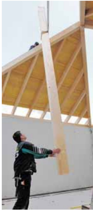
Die Arbeiter stellen mithilfe des Krans Gratspannen auf.
