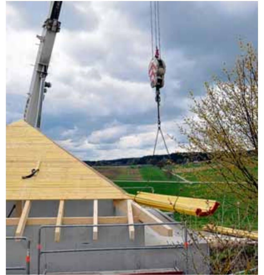
Wenn die Bauarbeiten in wenigen Monaten fertig sind, wird es im Vorführraum insgesamt 28 Sitzplätze geben.
